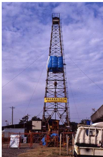
図 2 内海温泉のボーリング
